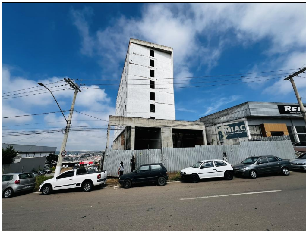
Figura 2: Fachada do Edifício Bristol. Fonte: perito, 2025.
