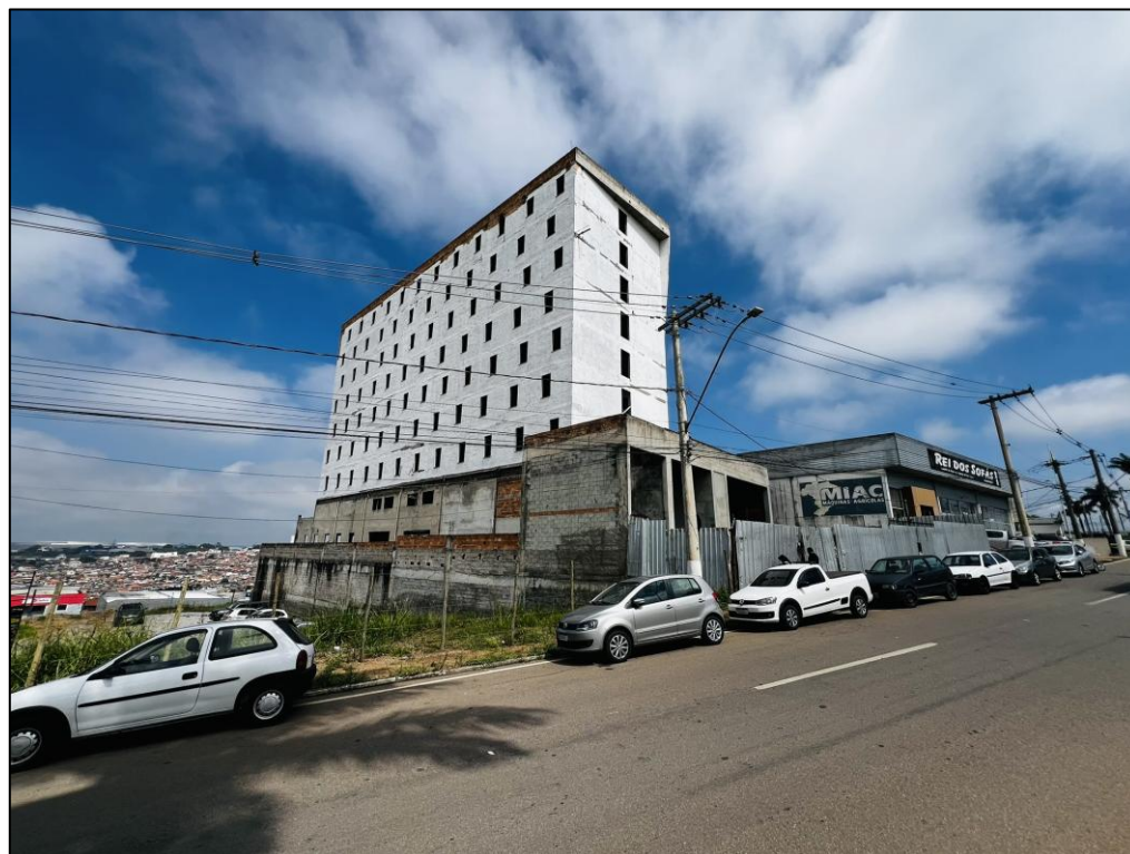
Figura 3: Fachada do Edifício Bristol. Fonte: perito, 2025.
