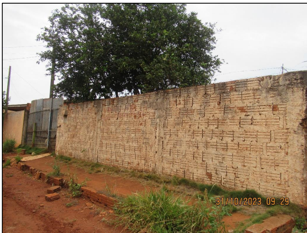
Imagem 4: Fachada do imóvel.
