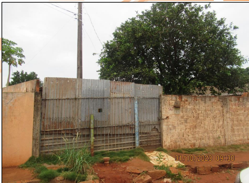
Imagem 3: Fachada do imóvel.
