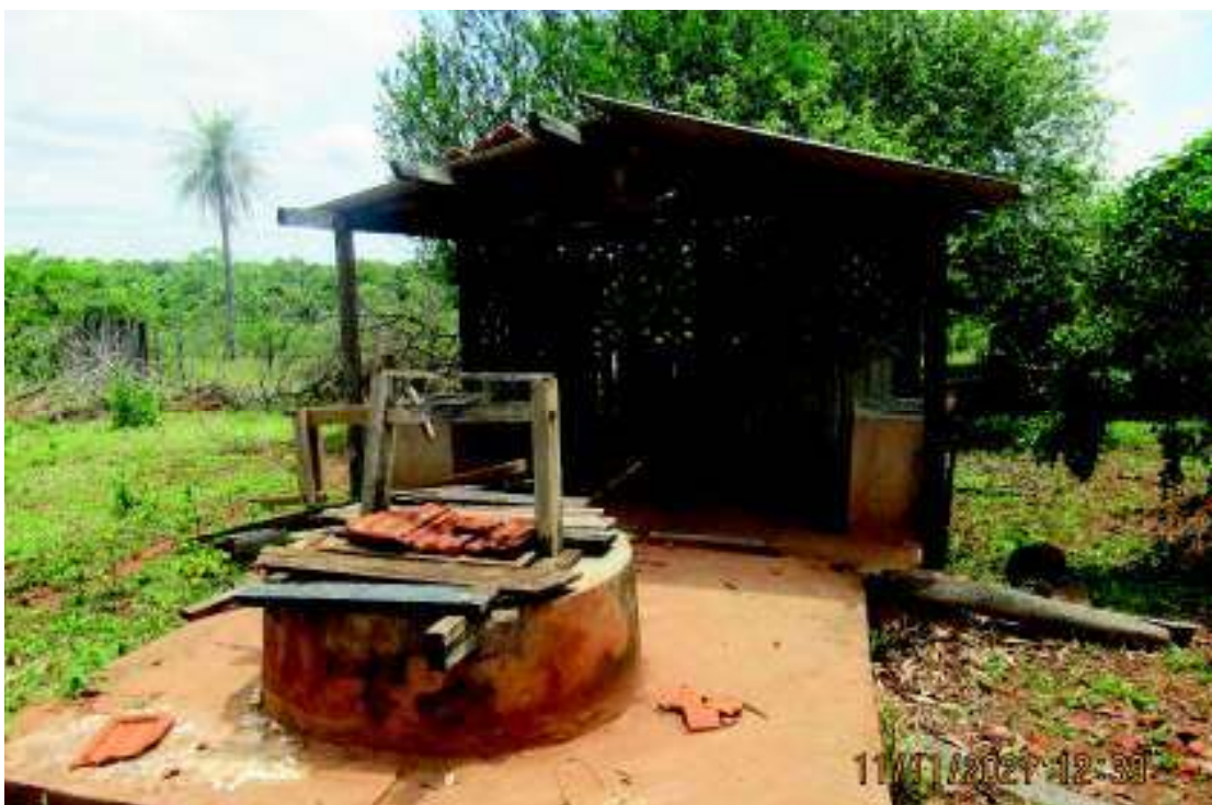
Imagem 15: Poço manual desativado (retiro).
