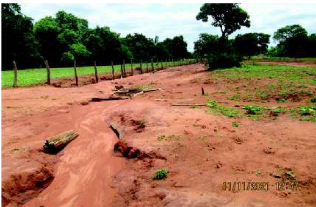
Imagem 13: Trecho de carreador malconservado, com indícios de erosão por sulcos.
