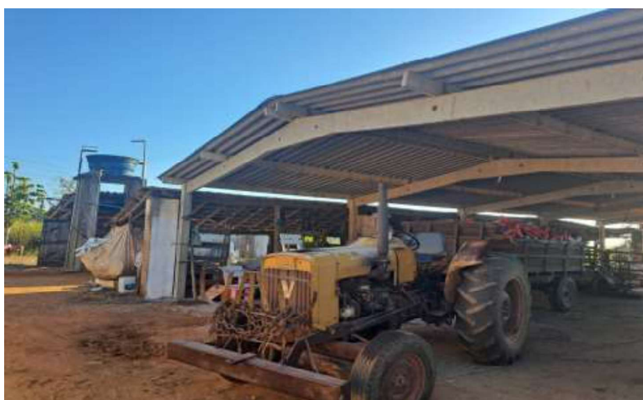
GALPÃO PARA ARMAZENAMENTO DE TRATORES E IMPLEMENTOS
