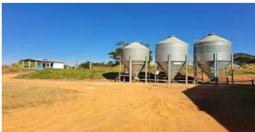
SILOS PARA ARMAZENAMENTOS DE GRÃOS
