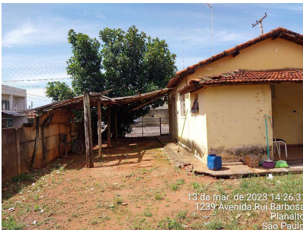
Foto 03: Vista externa do imóvel
