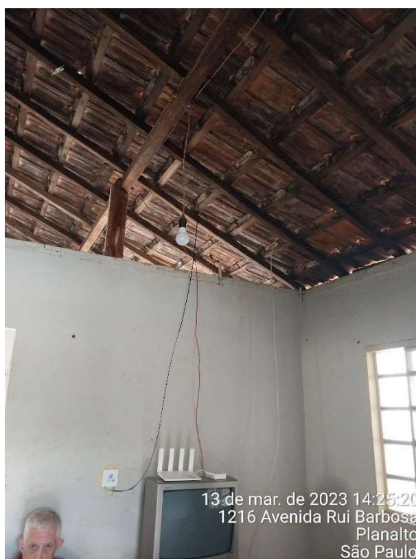
Foto 04: Vista interna - telhado
