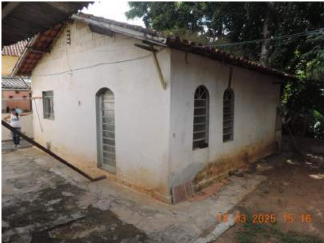
FOTO Nº 23 – VISTA EXTERNA DA EDIFICAÇÃO 2
