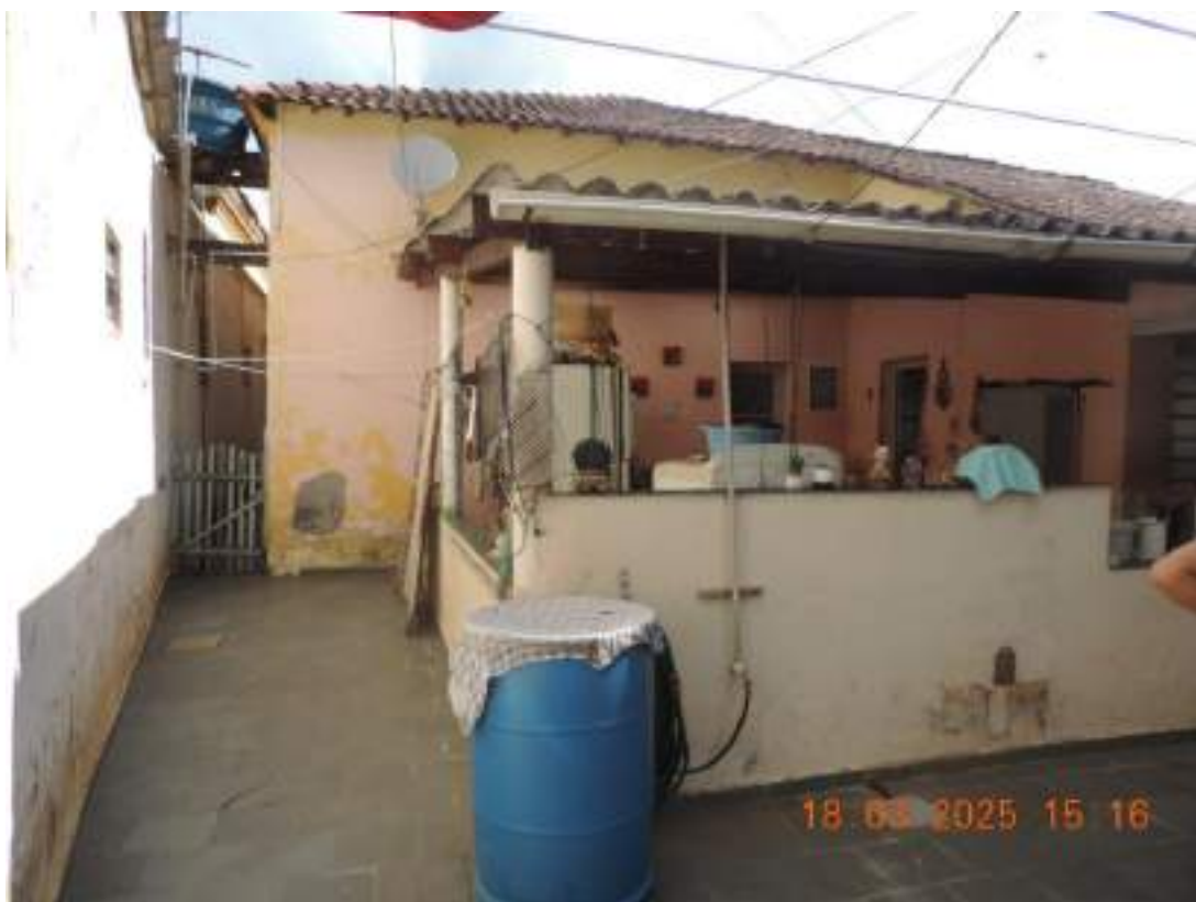
FOTO Nº 24 – VISTA EXTERNA DA EDIFICAÇÃO PRINCIPAL
