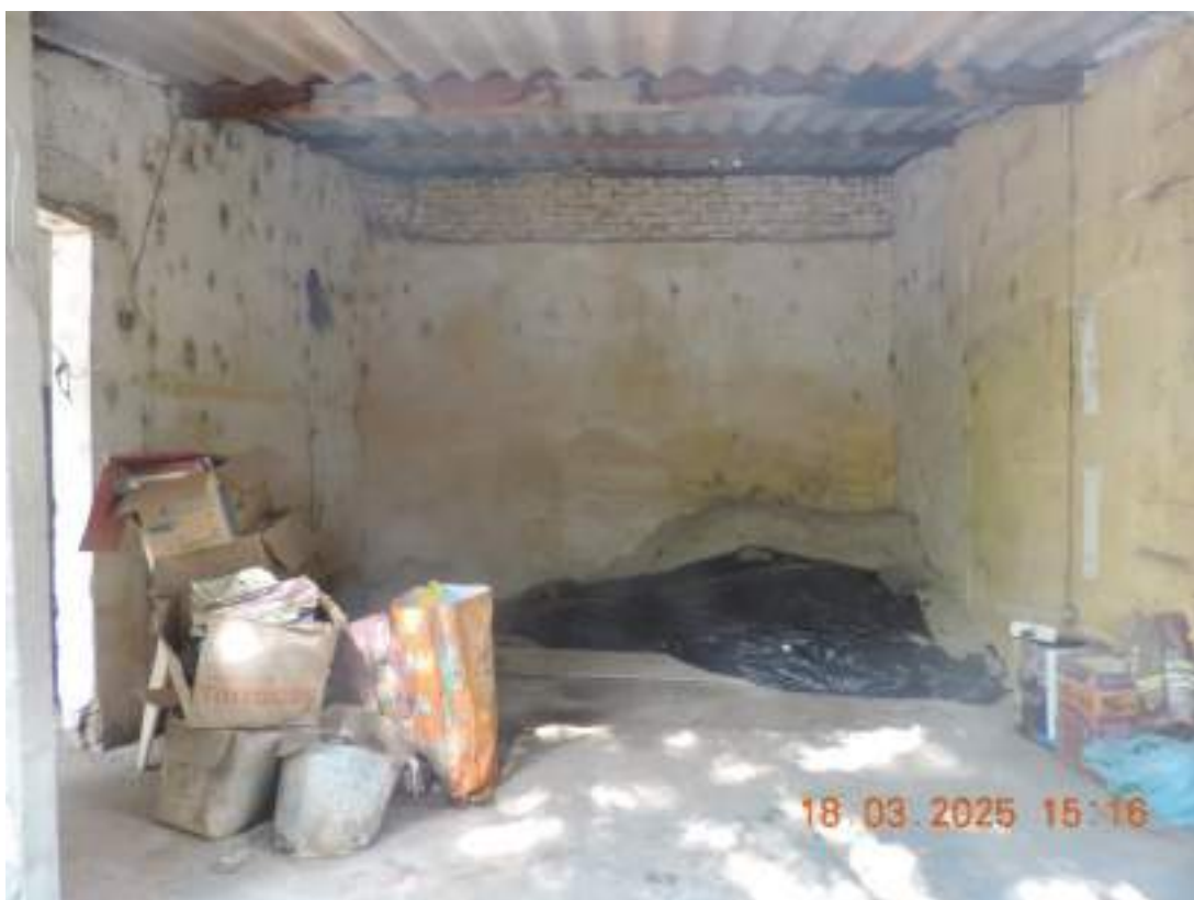
FOTO Nº 20 – VISTA INTERNA DA EDIFICAÇÃO DOS FUNDOS
