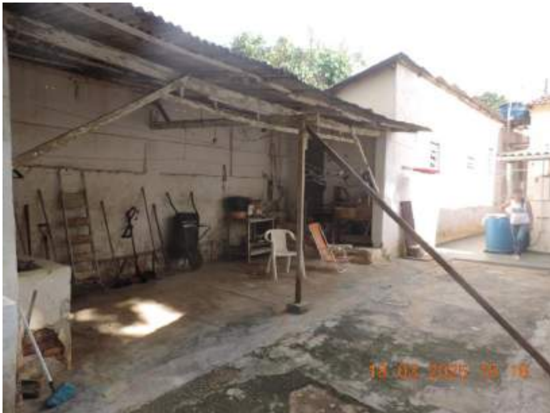
FOTO Nº 21 – VISTA INTERNA DA EDIFICAÇÃO DOS FUNDOS
