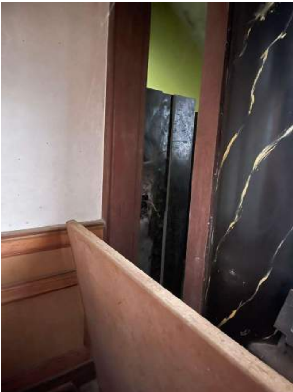
BANHEIRO 2 - SALÃO COMERCIAL
