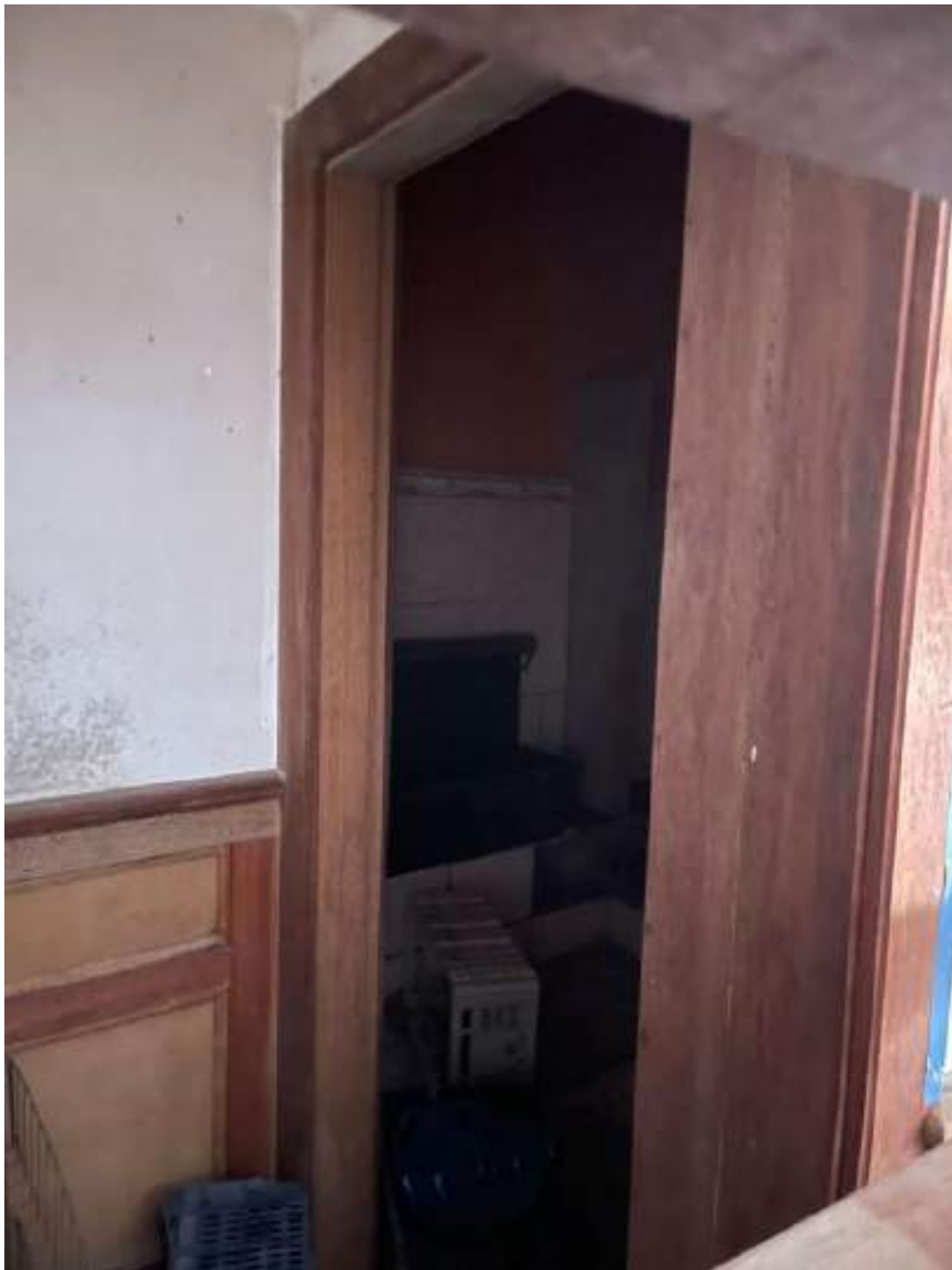
BANHEIRO 1 - SALÃO COMERCIAL
