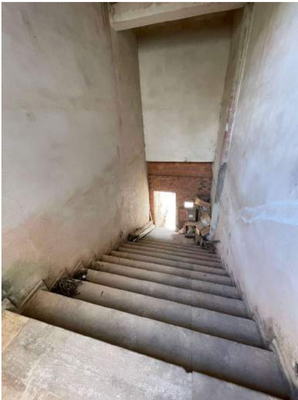
ACESSO ESCADA – 2.º PAVIMENTO
