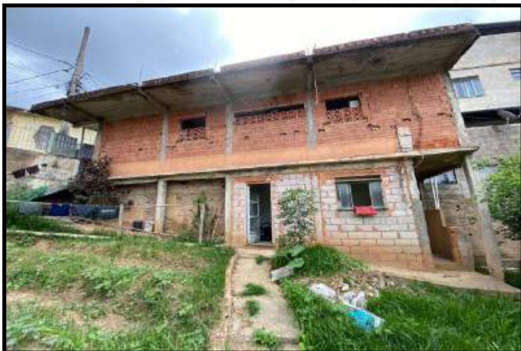
VISTA LATERAL DA GARAGEM
