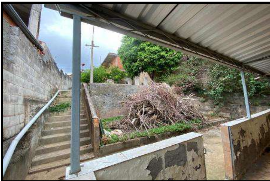
ESCADA DE ACESSO A RESIDÊNCIA
